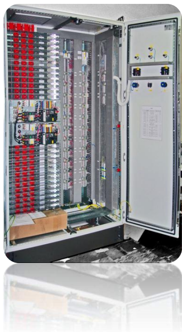
РТЗО-88 – распределительное токовое задвигное оборудование
